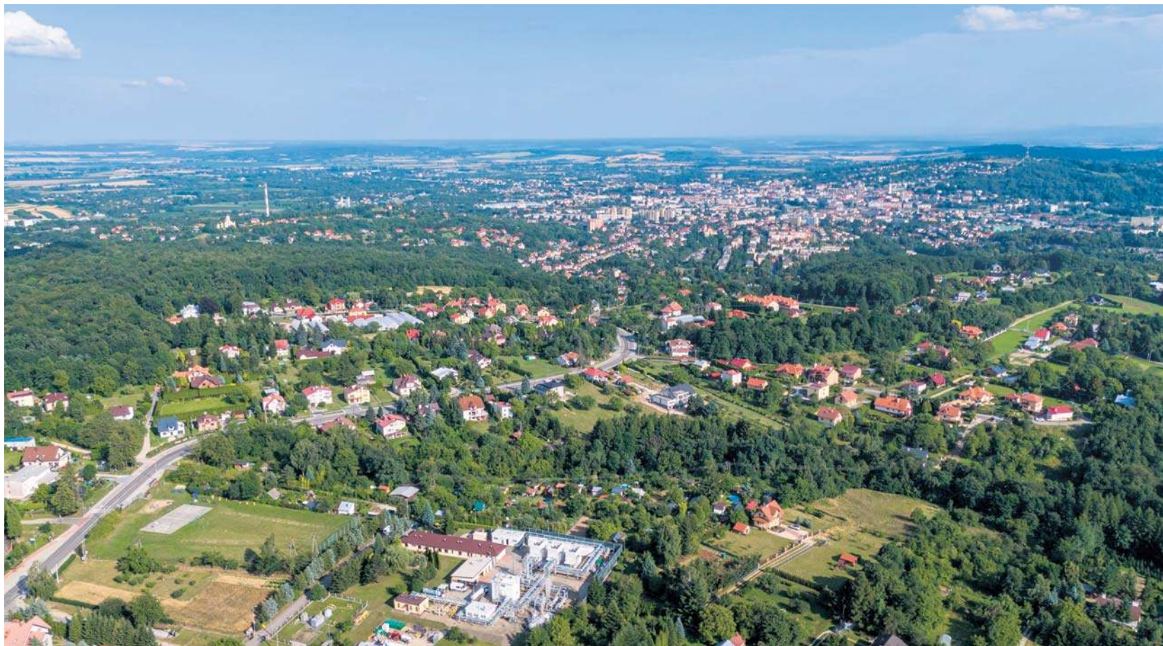
Instalacje gazowe ORLEN-u często sąsiadują z osiedlami mieszkaniowymi. Na zdjęciu Kopalnia Gazu Ziemnego Przemysł-Zachód (na pierwszym planie)
