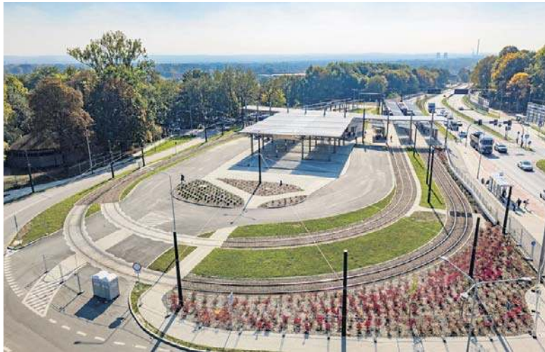
Budowę dworca na nowej pętli zakończono latem tego roku
