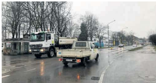
Przebudowa ulicy Piłsudskiego będzie kosztować około 5,5 miliona złotych. Wykonawcą jest Strabag
