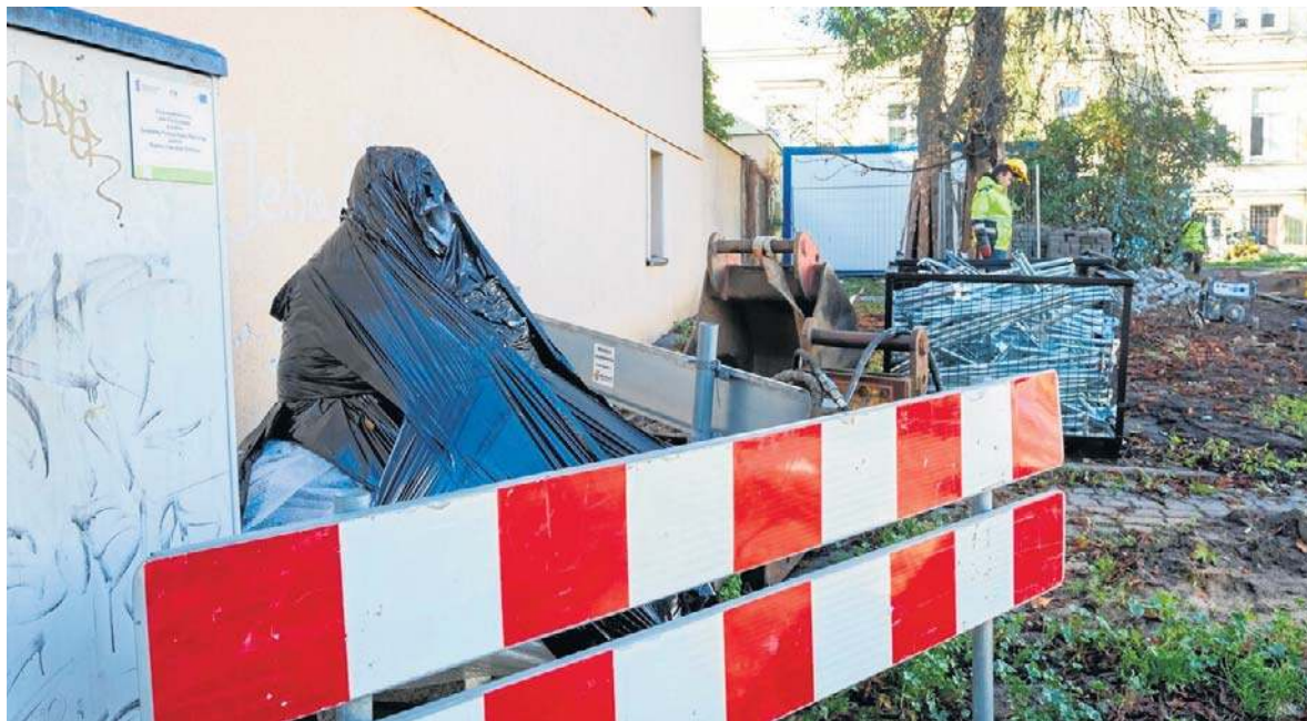
Prace związane z budową zbiornika retencyjnego u zbiegu ul. Śniadeckich i Gdańskiej sprawiły, że pomnik Mariana Rejewskiego tymczasowo spotkał taki los
