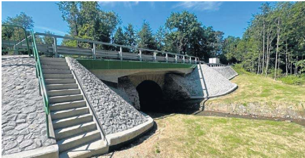
W Ślemieniu nowy most powstał na zabytkowej konstrukcji łukowej
