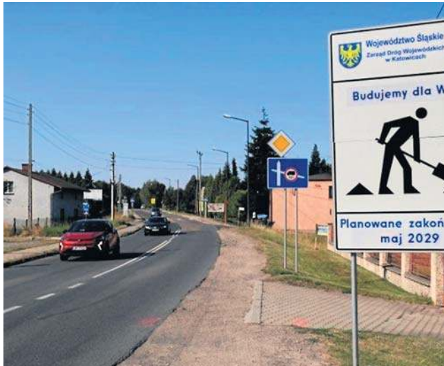
Drogowcy całkowicie wyłączyli z ruchu odcinek DW 935 w Rzuchowie
