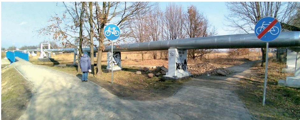
Nowa ścieżka spotka się z ubiegłoroczną biegnącą przez kładkę na Krznie (po lewej) i podąży przebudowaną techniczną drogą dojazdową (po prawej)
