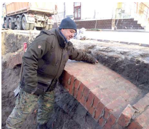
Archeolog Mieczysław Bienia podczas prowadzenia prac i nadzorów na terenie budowy przy ul. Krótkiej. Obok jego głowy w woreczkach są wydobyte fragmenty ceramiki i kafli
