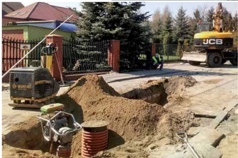
W różnych częściach Pułtusk trwa budowa sieci kanalizacyjnej
