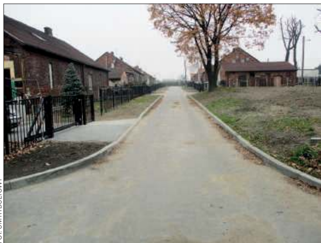
W pierwszym etapie prac wykonano m.in. drogi między budynkami
