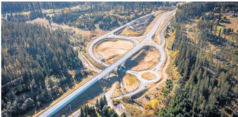
Most w Lalikach zostanie wyremontowany
