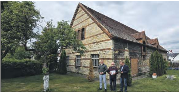
Remont obejmuje dach budynku
