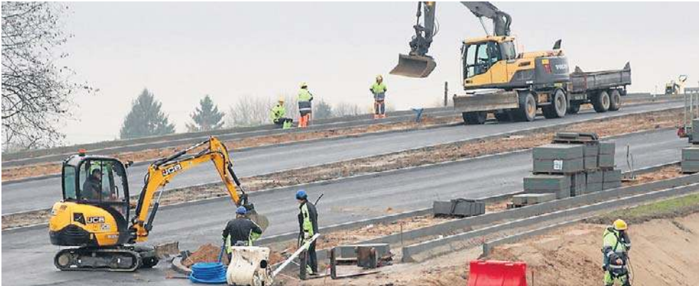
Trwają intensywne prace budowlane przy budowie łącznika
