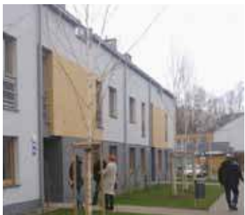
Na ulicy Śniadeckiego 13 STBS wybuduje kolejne 33 mieszkania. Będą to mieszkania jedno i dwupokojowe
