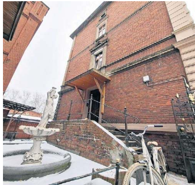
Kamienica przy Czarotoryskiego, w której - zdaniem części lokatorów - odbywa się dramat
