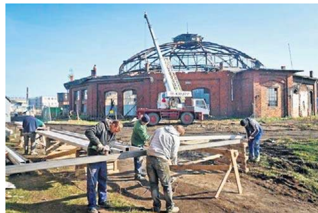
Rozbiórka starej parowozowni w Bydgoszczy. Według pierwotnych planów miała być odbudowana do 2017 r.
