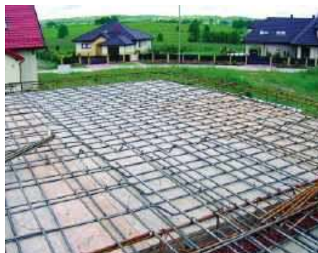
🔧 Budowa stropu żelbetowego zajmuje sporo czasu i wymaga wysiłku fachowców, którzy potrafią ułożyć skomplikowane zbrojenie. STALEXPORT
