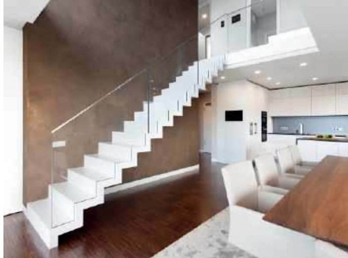
🔦 Balustrada pełna, bez pochwytu, wykonana ze szkła hartowanego, laminowanego. TRĄBZYŃSKI
