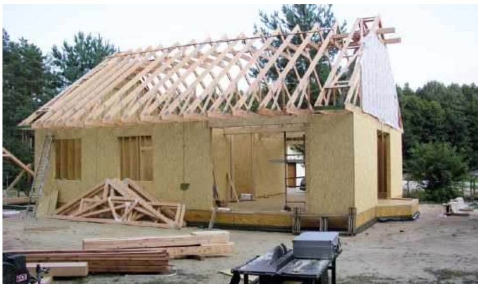
Poszyciem konstrukcji ścian szkieletowych mogą być płyty OSB, które charakteryzuje wysoka odporność na wilgoć i niska nasiąkliwość. KRONOPOL
