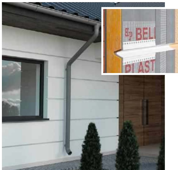
📍 Ściana dwuwarstwowa ocieplona metodą lekką mokrą i obłożona tynkiem. Efekt boniowania uzyskano dzięki zastosowaniu specjalnych listew elewacyjnych. BELLA PLASTER
