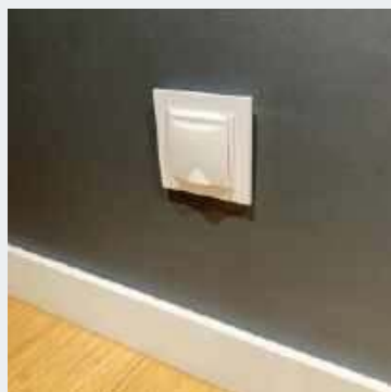
➤ Gniazda ssawne ulokowano 30 cm nad podłogą.
