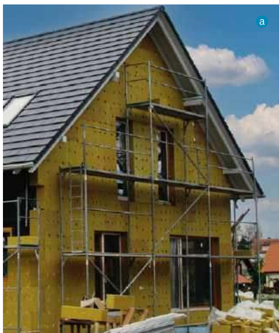
(a) Wełną ociepla się nie tylko poddasza, ale również ściany ( a ISOVER) i dachy płaskie ( b ROCKWOOL).
