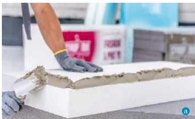
📍 Dwa najpopularniejsze materiały ociepleniowe: biały styropian (a STYROPMIN) i wełna mineralna, tu w rolce do ocieplania poddaszy (b URSA).
