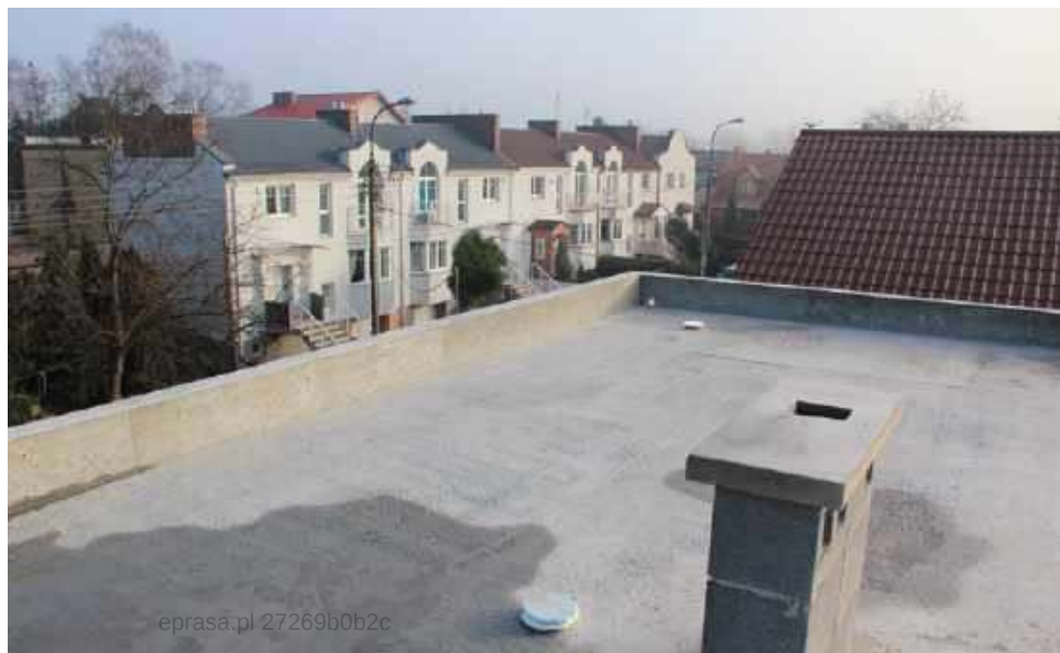
☀ Żelbetowa konstrukcja dachu płaskiego, czyli strop nad ostatnią kondygnacją. J. WERNER
