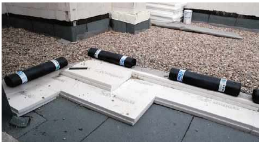
❶ Polistyren ekstrudowany XPS jako ocieplenie dachu płaskiego odwróconego. SYNTHOS
