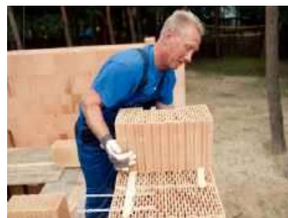
Pustaki z ceramiki poryzowanej są lżejsze od tradycyjnych. WIENERBERGER
