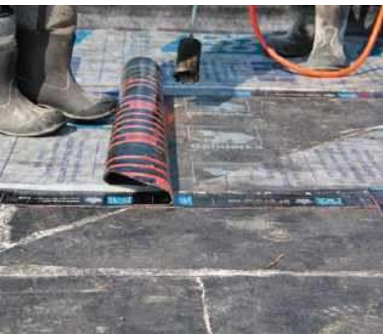
🔥 Zgrzewanie papy podkładowej. J. WERNER
