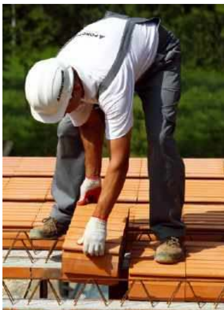
🔧 Układanie ceramicznych pustaków w stropie gęstożebrowym. Dużą zaletą tej technologii jest prosty montaż i brak konieczności użycia ciężkiego sprzętu. WIENERBERGER
