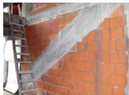
☝ Umieszczenie w ścianie nośnej belki konstrukcyjnej schodów wspornikowych, jednostronnie osadzonych w ścianie. J. WERNER
