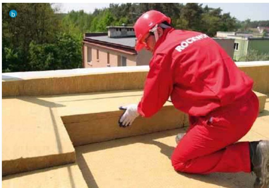
(a) Wełną ociepla się nie tylko poddasza, ale również ściany ( a ISOVER) i dachy płaskie ( b ROCKWOOL).
