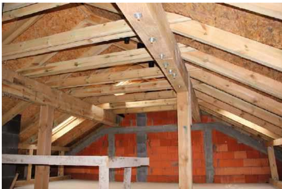
📍 Tradycyjna więźba dachowa z deskowaniem z płyt OSB. J. WERNER
