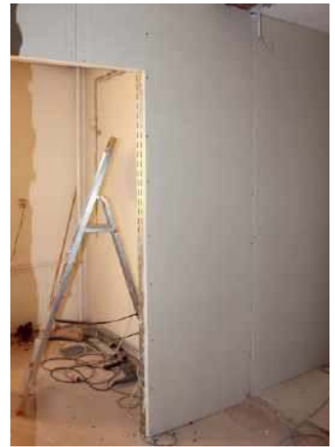
❷ Wydzielenie pomieszczenia ścianą działową. J. WERNER
