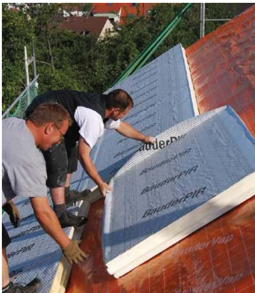
🔗 Płyty z piany PIR mocowane nakrokwiowo. BAUDER
