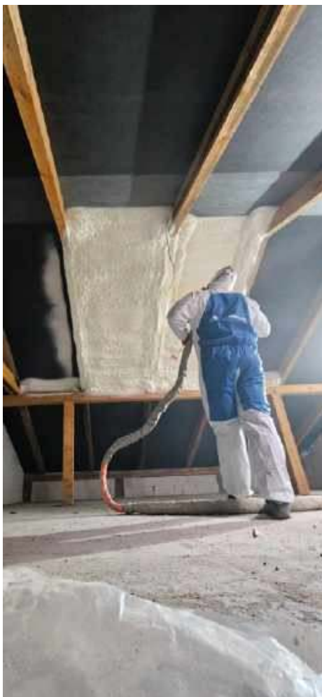
(c) Do ocieplenia poddasza pianą PUR trzeba zatrudnić profesjonalistów. ULTRAPUR
