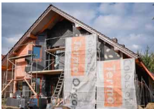
📍 Najpopularniejsza w naszym kraju metoda ocieplania ścian – lekka mokra. Izolację cieplną przykleja się do muru i pokrywa tynkiem cienkowarstwowym. TERMO ORGANIKA
