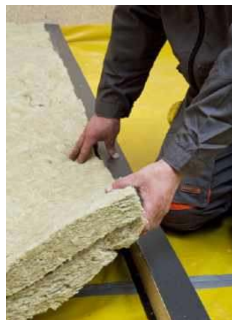
🔧 Najlepszą metodą na poprawę izolacyjności termicznej stropu drewnianego jest ułożenie między legarami wełny mineralnej. PFLEIDERER
