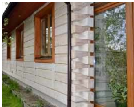
Bale wykorzystywane do wznoszenia ścian mają rozmaity przekrój i grubość. Wykonuje się je z ostruganego, zaimpregnowanego drewna. L. JAMPOLSKA
