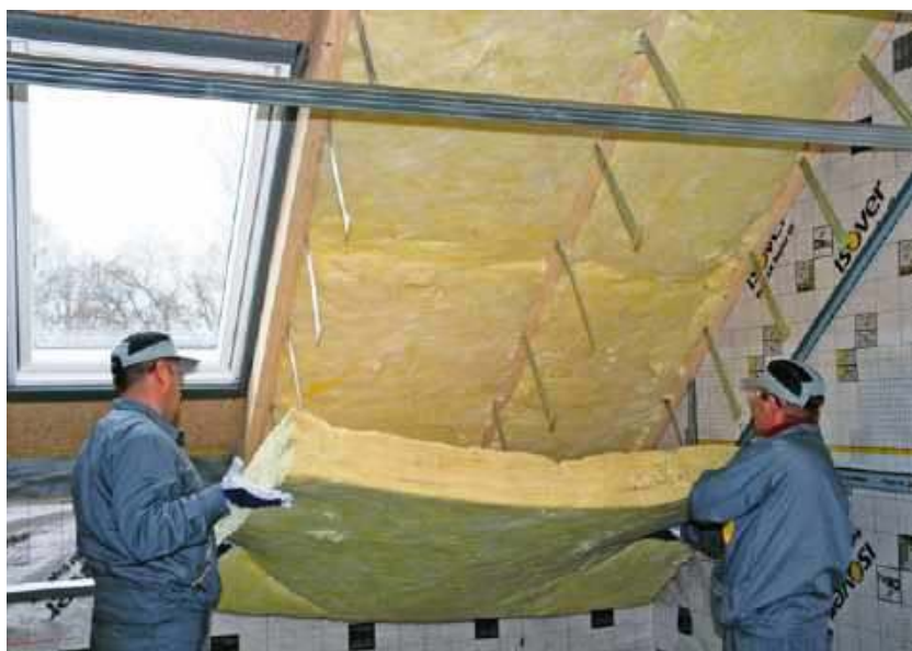
🔗 Wełnę na połaci dachu skośnego układa się w dwóch warstwach. ISOVER
