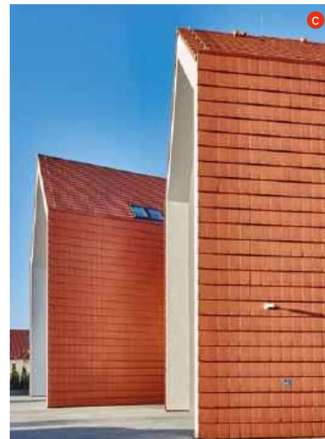
❶ Dachówką można wykończyć fragment elewacji (a), albo całe ściany (b, c). WIENERBERGER
