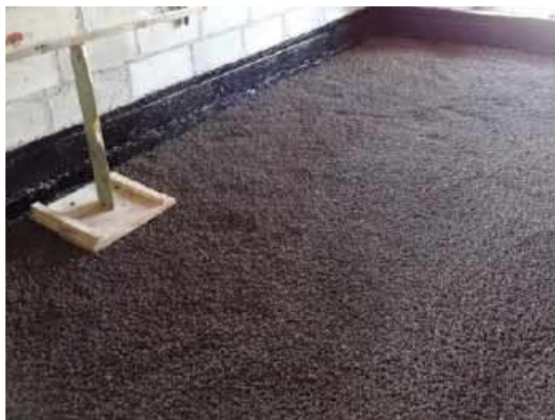
🔗 Ocieplenie podłogi na gruncie z keramzytu. SAINT-GOBAIN
