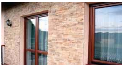
Elewacje z kamienia są bardzo trwałe, ale ciężkie, dlatego mocuje się je na zaprawę cementową. BRUK-BET
