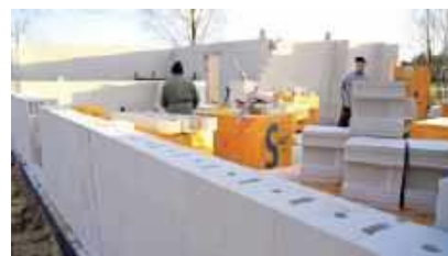
Silikaty mają wyprofilowane powierzchnie boczne oraz uchwyty montażowe. H+H
