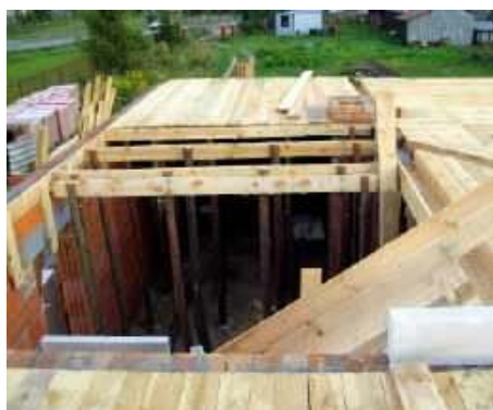
🔧 Wykonanie stropu monolitycznego zajmuje dużo czasu, bo trzeba wykonać szalunek, ułożyć zbrojenie, przykryć je mieszanką betonową i poczekać aż się utwardzi i osiągnie wymaganą wytrzymałość. M. SZYMANIK
