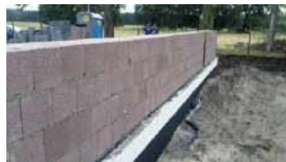
Ściany z keramzytobetonu muruje się z użyciem zaprawy cementowo-wapiennej. CZAMANINEK
