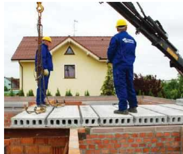
🔧 Prefabrykowany strop panelowy można ułożyć w dwie godziny, bez konieczności korzystania z ciężkiego dźwigu, wystarczy samochód z dźwigiem typu HDS. STROPY.PL
