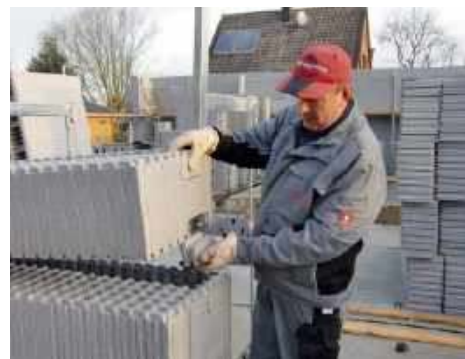
Klocki ze styropianu układa się warstwowo, wypełnia zbrojeniem i zalewa betonem. Żelbetowy rdzeń zapewnia konstrukcji sztywność. Wewnętrzna i zewnętrzna warstwa styropianu stanowią ochronę wewnątrz przed ucieczką ciepła. IZODOM 2000 POLSKA
