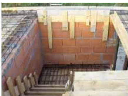
☝ Wylewane schody dwubiegowe – widoczny szalunek górnego biegu i zbrojenie spocznika. M. SZYMANIK
