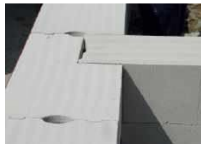
Przemurowanie ścian z betonu komórkowego. SOLBET
