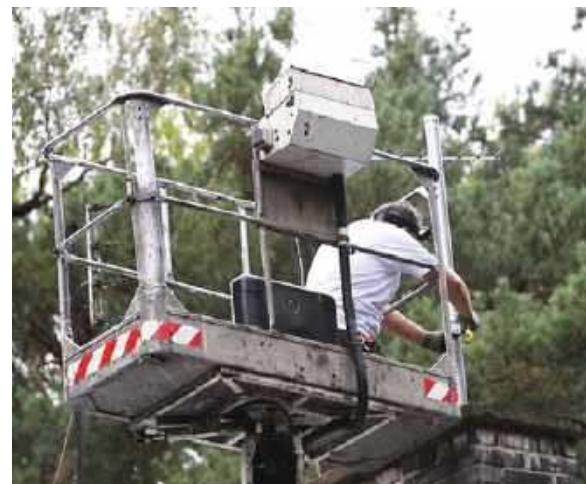
🔧 Wymiana kotła bardzo często wiąże się z koniecznością wyposażenia kominą we wkład odporny na kondensat. VISSMANN
