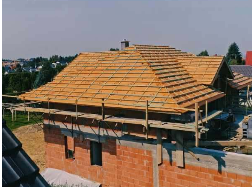
Konstrukcja i warstwa podkładowa dachu skośnego gotowe. MARMA POLSKIE FOLIE
