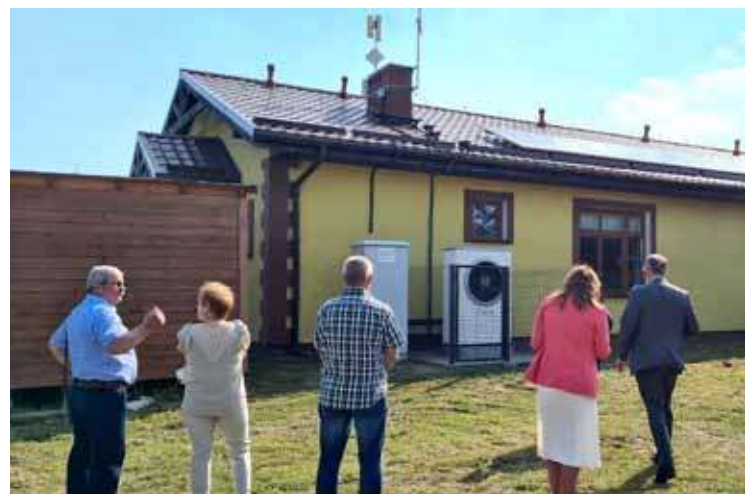
W Gminie Ińsko zakończyła się inwestycja polegająca na modernizacji sposobu ogrzewania w świetlicy w Studnicy i Ciemniku
