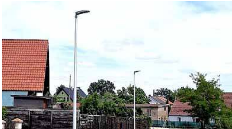
Na ulicy Grudziądzkiej zamontowano 7 nowych słupów, które dają mocne światło, jednocześnie pobierając niewiele energii
