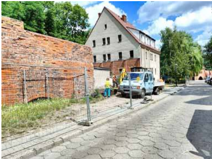
Cenne historyczne mury zostaną wzmocnione i zabezpieczone przed niekorzystnymi warunkami atmosferycznymi
