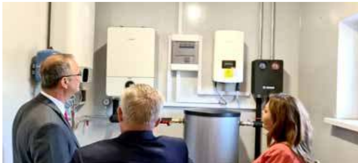
W ramach prac zamontowano nowe pompy ciepła oraz panele fotowoltaiczne
