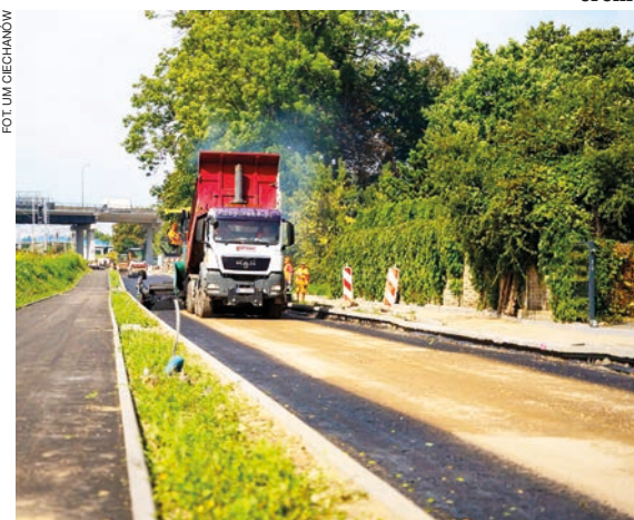
Prace na ulicy Fabrycznej
