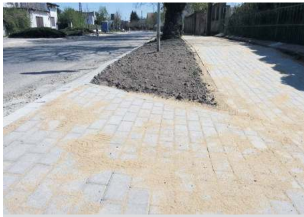
W wielu miejscach na ul. Brzegowej pomiędzy jezdnią a chodnikiem z betonowych puzzli pozostawiono wysepki wypełnione ziemią, które obsiane zostaną trawą
