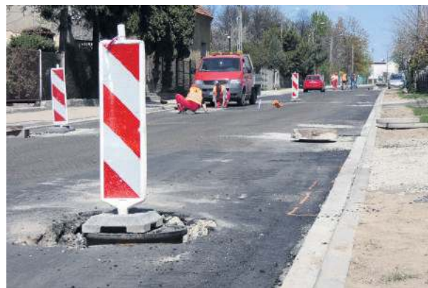
Na ul. M. Konopnickiej obecnie trwają prace przy montowaniu studzienek kanalizacyjnych i wodociągowych
