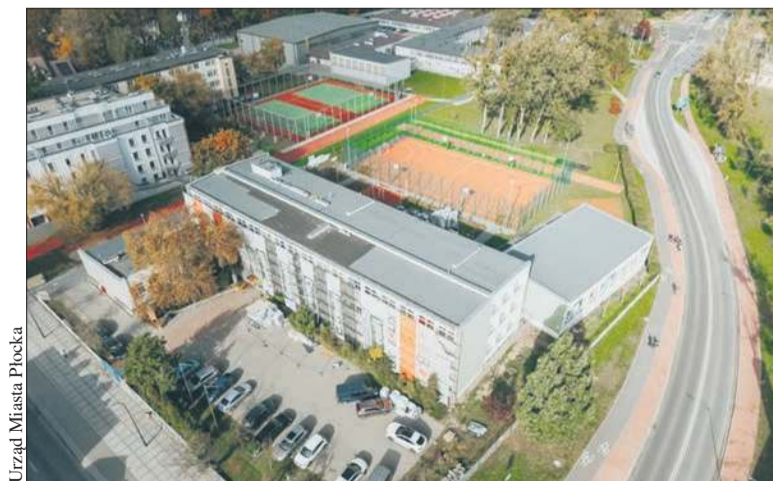
Dobiega końca termomodernizacja budynku płockiego „Ekonomika”
