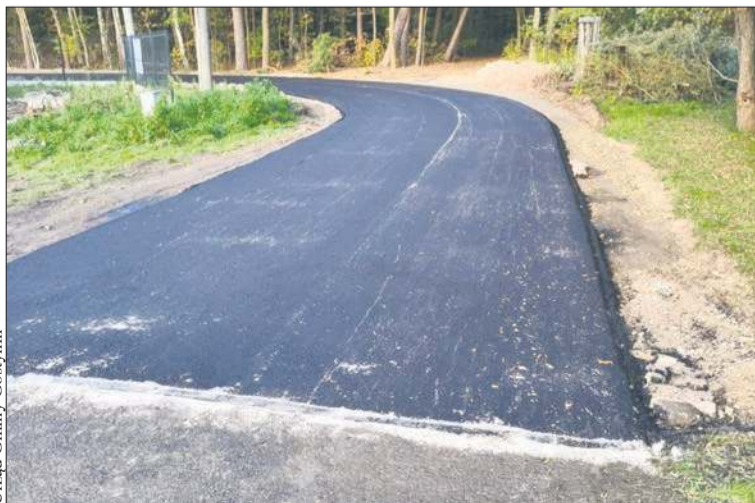
Przebudowa drogi w Bierzewicach
