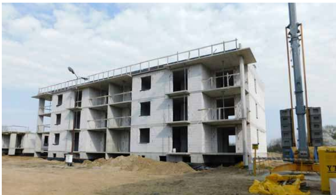
Jeden z sześciu nowo powstających budynków
