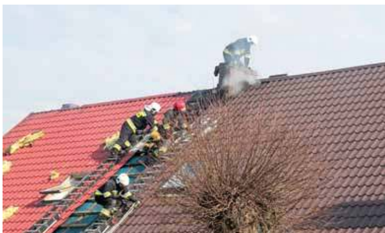
Strażacy po ściągnięciu części blaszanej pokrywy dachowej szukają i likwidują żarzewia ognia
