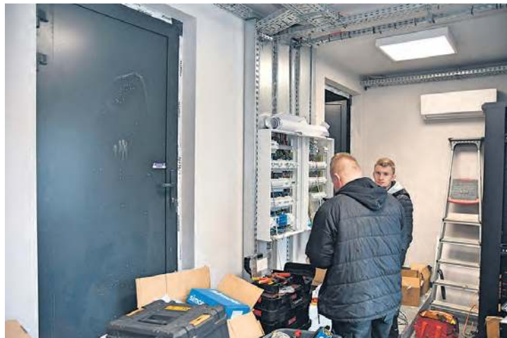
Aktualne prace dotyczą m.in. elektryki w obiekcie.
