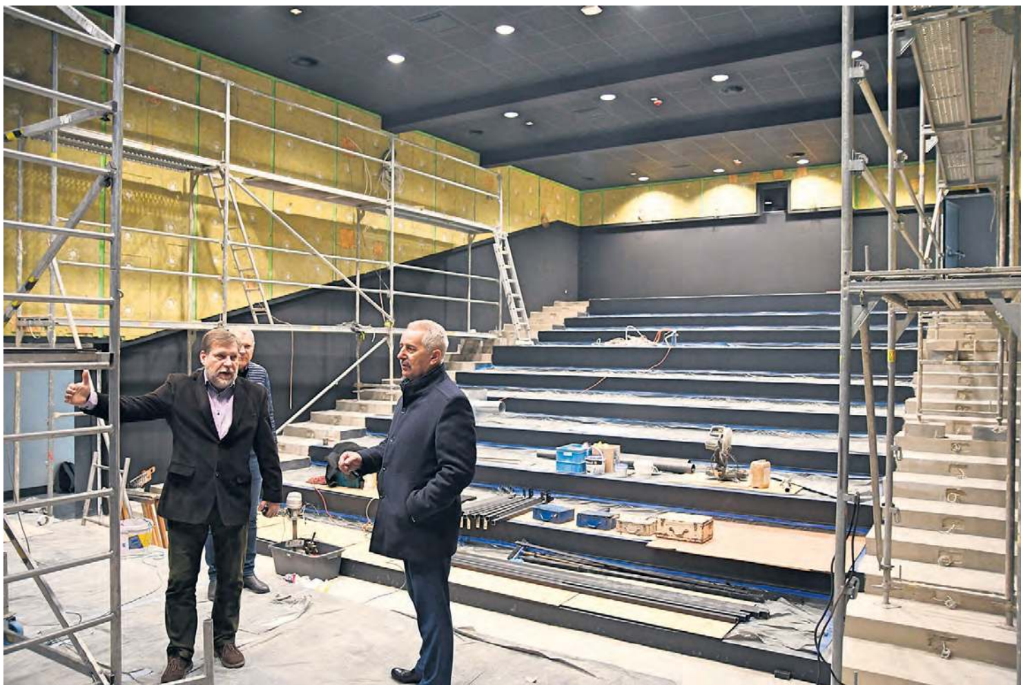
Widok na przyszłe rzędy, gdzie zamontowane zostaną fotele. Dostępnych będzie 138 miejsc.
