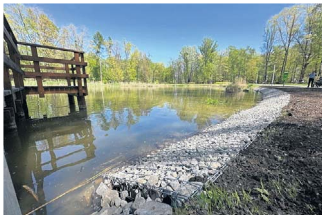
Skarpa stawu została wzmocniona kamieniem, nawieziono świeżej ziemi i zasiano trawę
