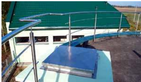
Mieszkańcy doceniają tak niezbędne inwestycje jak rozbudowa stacji uzdatniania wody w miejscowości Wiśniew
