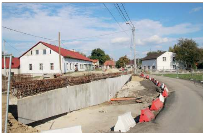
Na dokończenie modernizacji drogi w Janowicach będzie należało poczekać kilka miesięcy...
