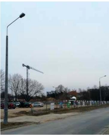
Część latarni już została wymieniona
