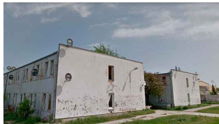
Przetwórnia ma powstać zaledwie 90 metrów od bloków socjalnych przy ul. Grygowej
