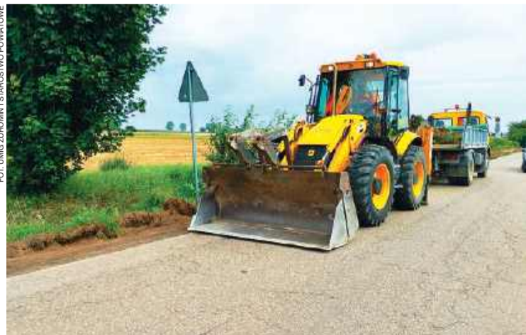
Sprzęt gotowy do robót na drodze powiatowej
