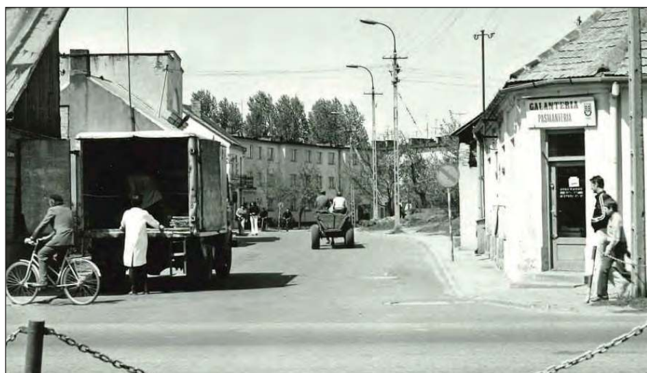
Ulica Warszawska, widok fragmentu pierzei północnej, strony prawej (fot. Lubelski Wojewódzki Konserwator Zabytków w Lublinie)
