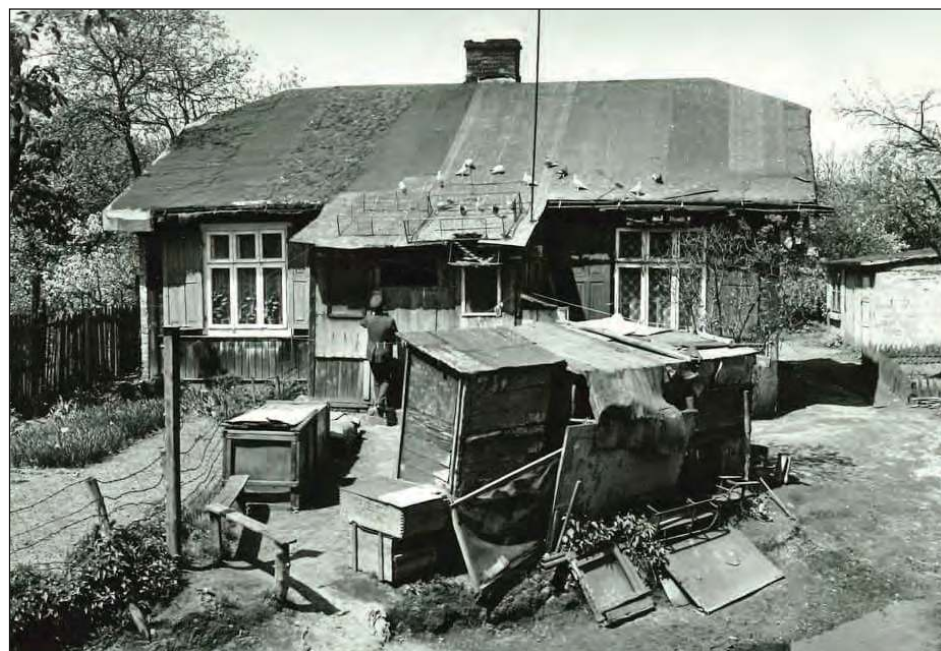
Zabudowa przy trasie prowadzącej wzdłuż rzeki Irenki ku Szkole Lotniczej (fot. Lubelski Wojewódzki Konserwator Zabytków w Lublinie)
