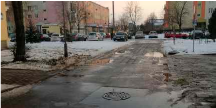
Jest szansa na remont końcowego odcinka ulicy Akacjowej
