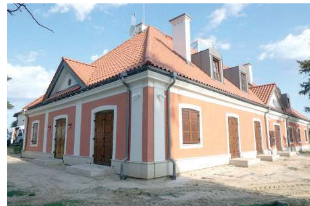
Już niedługo w odremontowanym budynku ratusza pojawi się część planowanego wyposażenia
