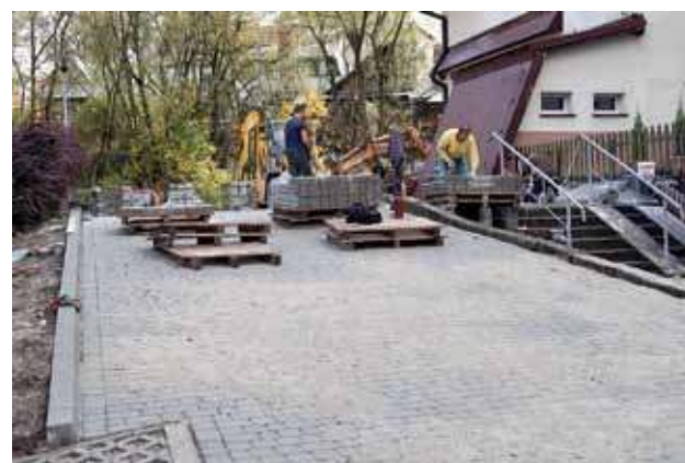
Na osiedlu przy ul. Szkolnej trwa układanie kostki brukowej. Część mieszkańców domaga się wyznaczenia szerszego chodnika.
