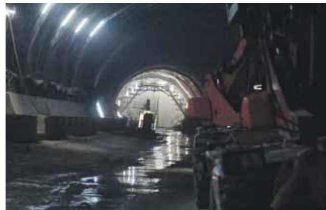
Czy wykonawca dotrzyma terminu i jeszcze w tym roku wszyscy pojedziemy nowym tunelem?
