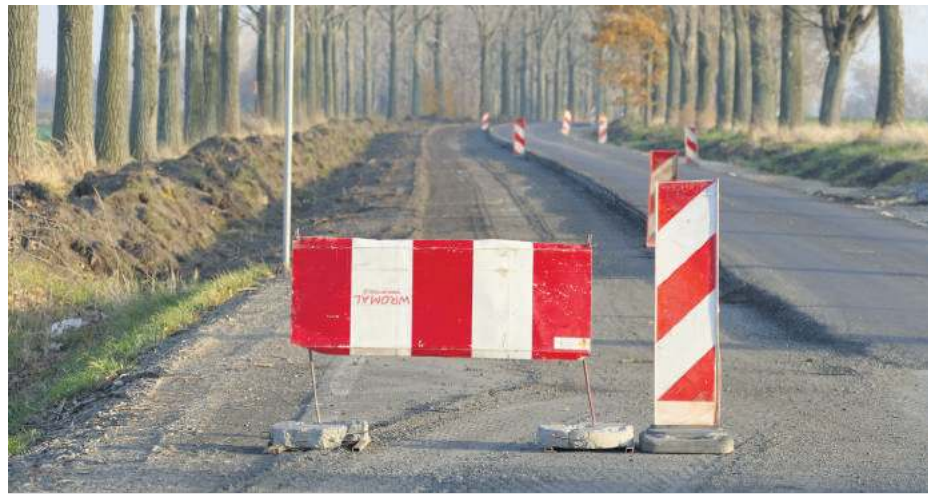
Pracownicy firmy Bergen Bau odtworzyli zniszczone oznakowanie
