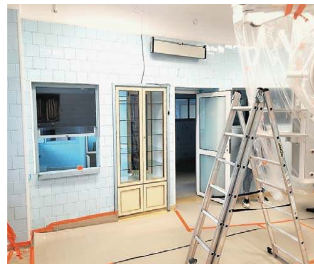
W szpitalu trwa remont bloku operacyjnego
