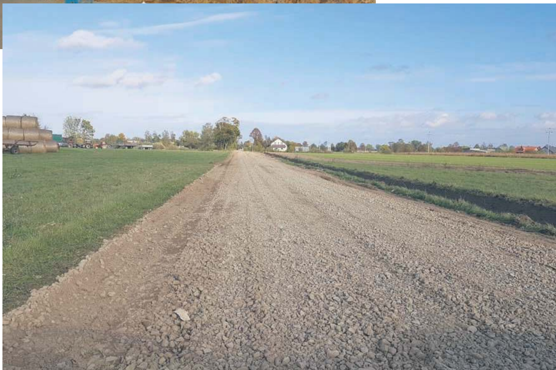
Remont drogi w miejscowości Radzanowo-Lasocin odbył się w ramach realizacji funduszu sołeckiego
