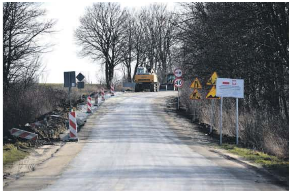
Rozpoczęła się przebudowa ok. 1,4 km jezdni w Szewcach na odcinku od ul. Nowej w kierunku Ozorowic
