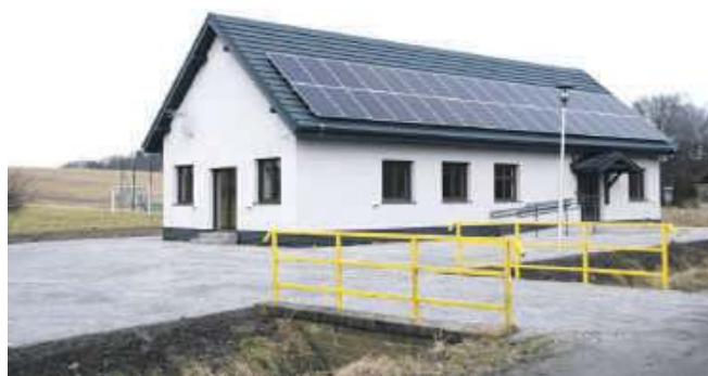
Natomiast w Machnicach na terenie przed nową świetlicą pozostało jeszcze zagospodarowanie placu zabaw dla najmłodszych mieszkańców miejscowości
