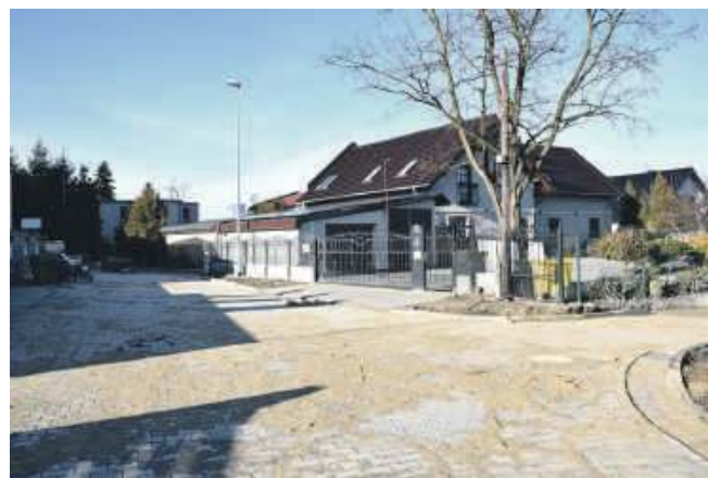
Budowa sięgacza ulicy Głównej w Psarach
