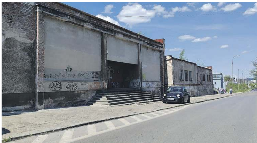
Dworzec PKP przy Fabrycznej w Chrzanowie
