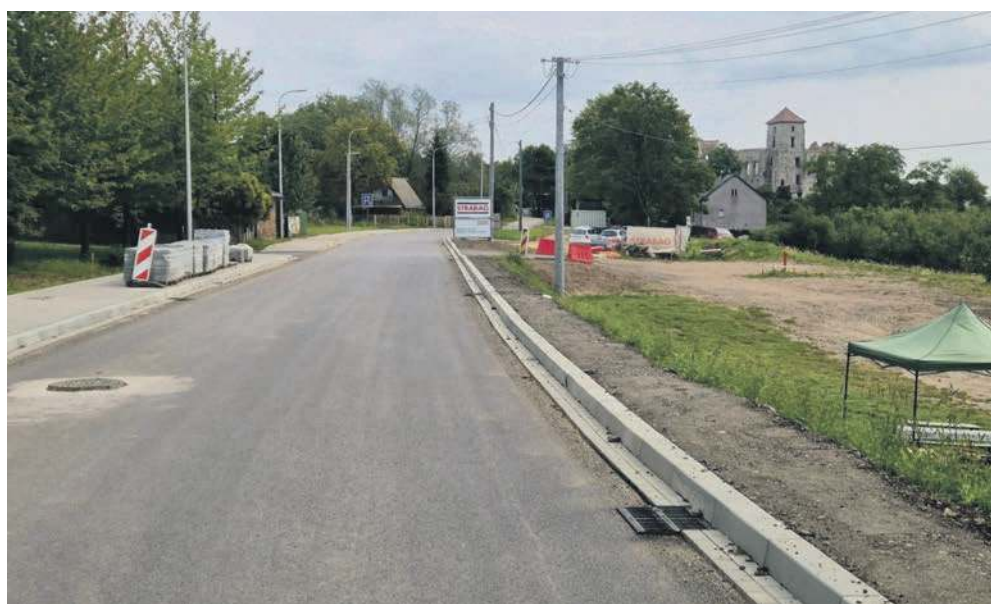
Nowa droga do zamku Tenczyn ma chodnik
