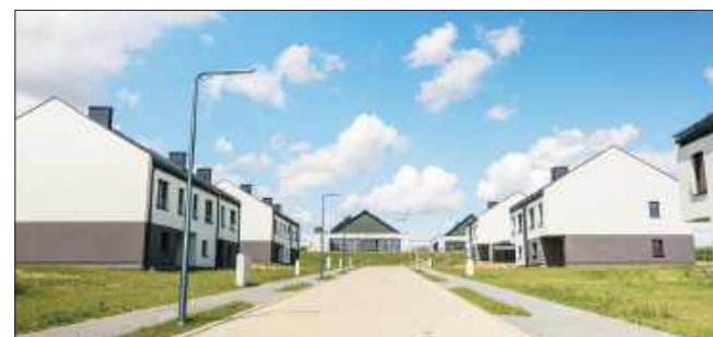
■ W malowniczej okolicy stanęło 28 domów jednorodzinnych w zabudowie bliźniaczej i szeregowej
