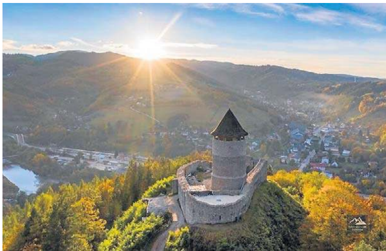
Rekonstrukcja baszty została zakończona, ale to nie koniec prac
