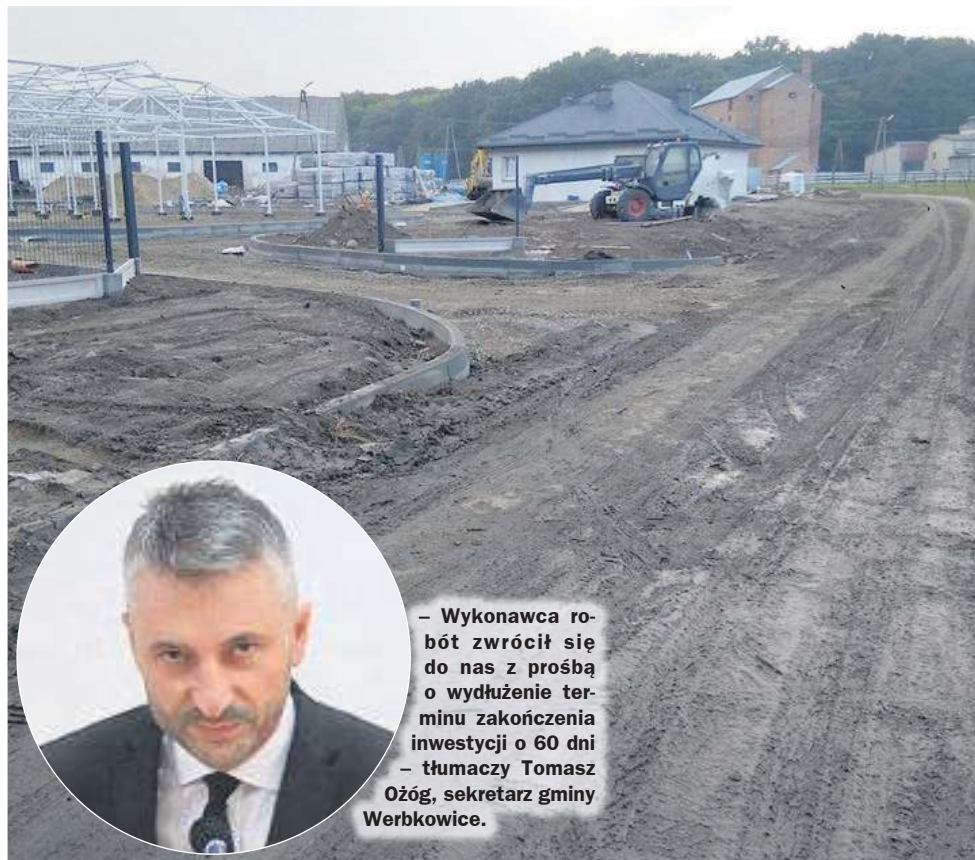
30 września budowa targowiska „Mój Rynek” w Werbkowicach miała zostać zakończona, a tak wyglądał plac budowy 3 dni wcześniej.
