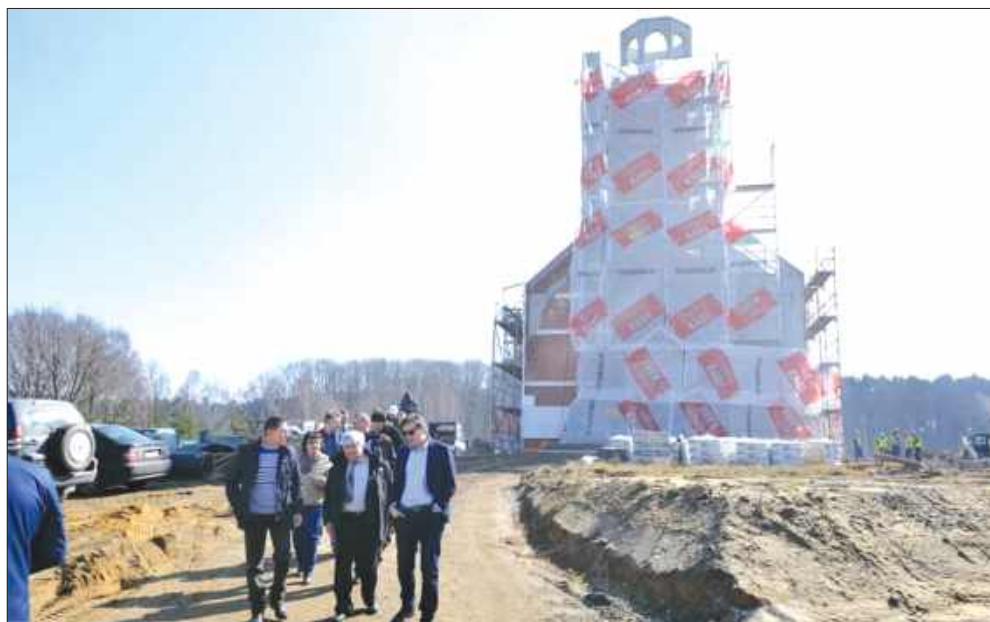
■ Wizyta przedstawicieli Banku Światowego na placu budowy odtwarzanych Nieboczów
