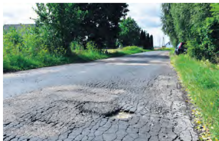
Niespodzianek takich, jak uwieczniona dziura na niewyremontowanym odcinku drogi powiatowej Zalesie – Stary Sumin, jest więcej. Fot. Anna Lipska
