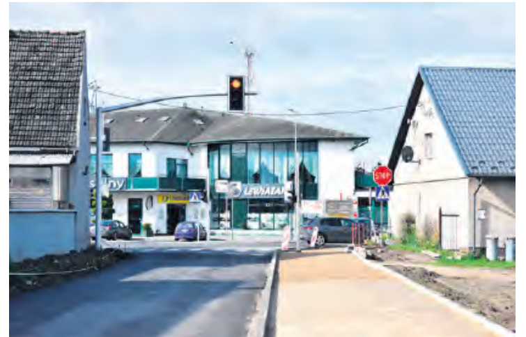
Proponowana przez radnego zmiana miałaby polegać na zdemontowaniu z górnej części konstrukcji sygnalizacji świetlnej i zamontowaniu jej na słupie stojącym z boku drogi powiatowej – na powstającej, nowej ścieżce pieszo-rowerowej.
