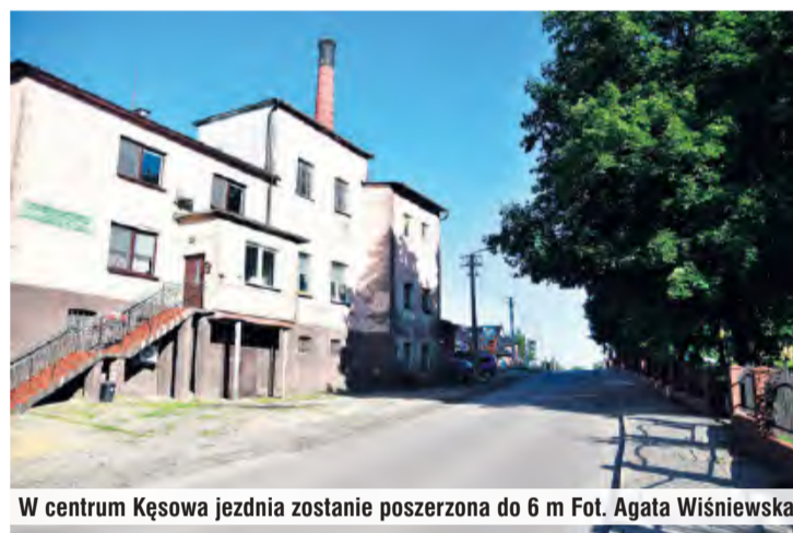
W Klonowie przebudowany zostanie odcinek o długości około 400 metrów, rozebrany zostanie wiadukt, w którego miejsce zaplanowane jest wybudowanie przepustu skrzynkowego. Fot. Anna Lipska
