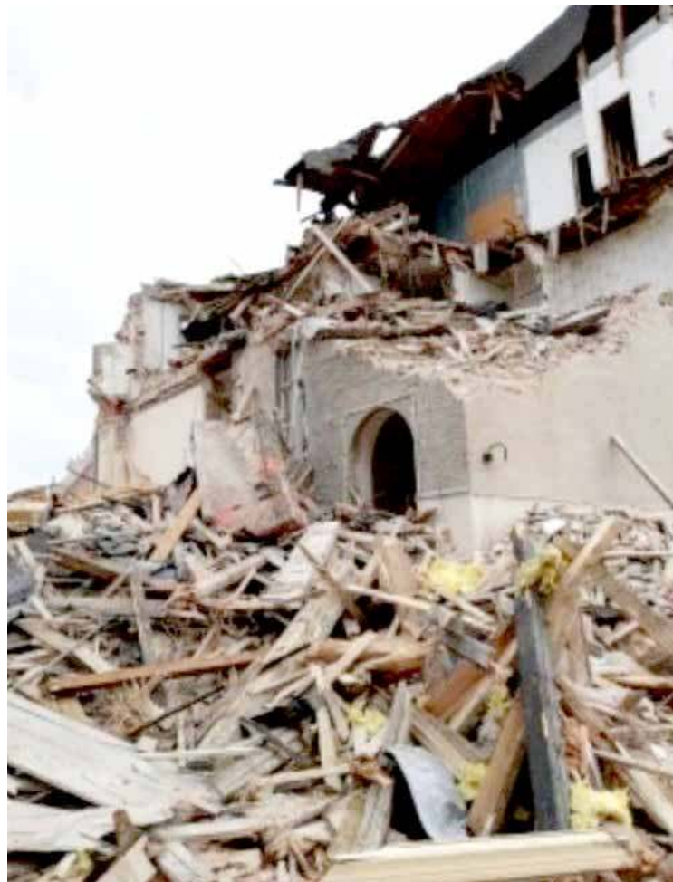
Zabytkowa kamienica przy ul. B. Chrobrego 21 została już rozebrana, teraz czekamy na jej odtworzenie
