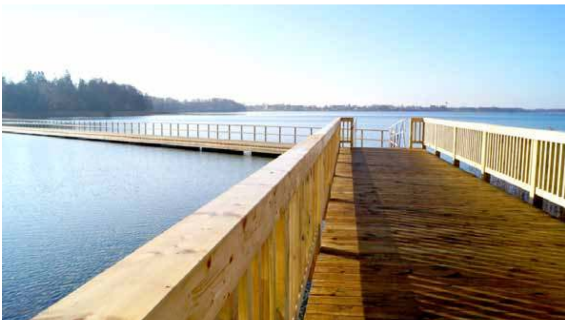
Pomost na Jeziorze Ińsko usytuowany jest wzdłuż linii brzegowej. Jego konstrukcja składa się z dwóch części, a długość wynosi 216 metrów
