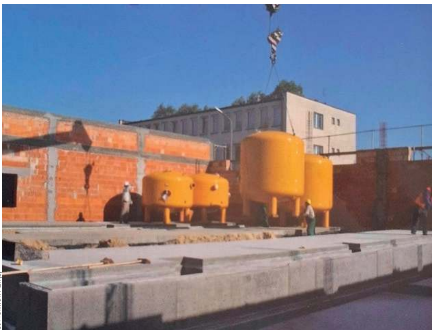
Budowa Stacji Uzdatniania Wody przy ulicy Komunalnej, październik 2007 r.
