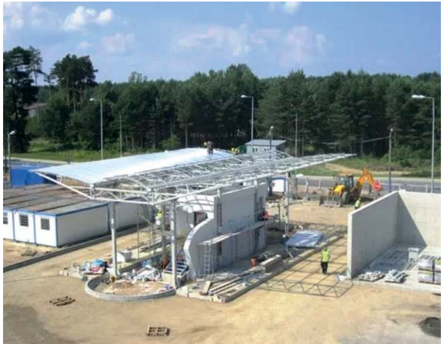
Budowa Zakładu Mechaniczno-Biologicznego Przetwarzania Odpadów w Stalowej Woli, archiwum MZK
