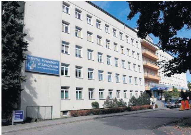
Szpital Powiatowy w Zakopanem planuje zbudować Zakład Opiekuńczo-Lecznicy
