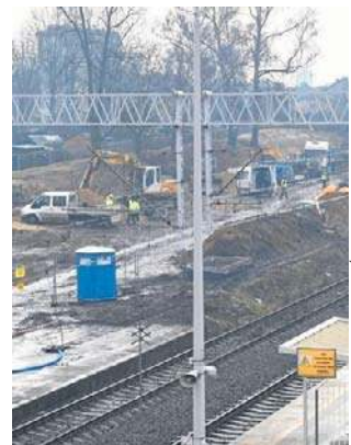
Przy stacji rozpoczęła się budowa parkingu
