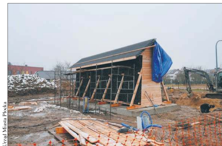
Budowa tężni w Imielnicy dobiega końca. Skwer, na którym się znajduje będzie gotowy w przyszłym roku
