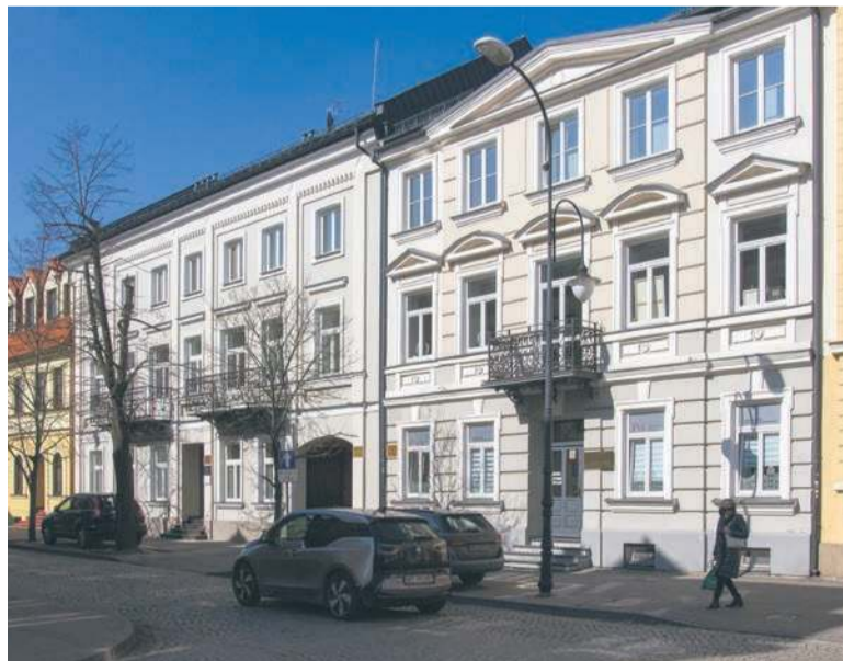
Odrestaurowane kamienice przy ul. Bielskiej
