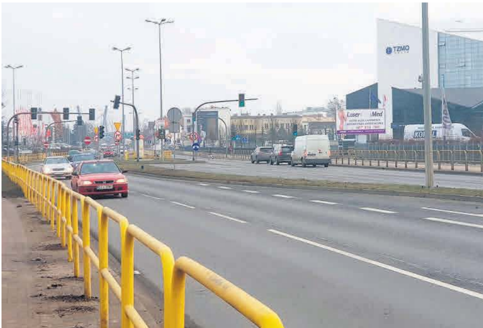
ULICĘ ŻÓŁKIEWSKIEGO , jedną z głównych arterii łączących centrum z wschodnią częścią miasta, czeka remont
