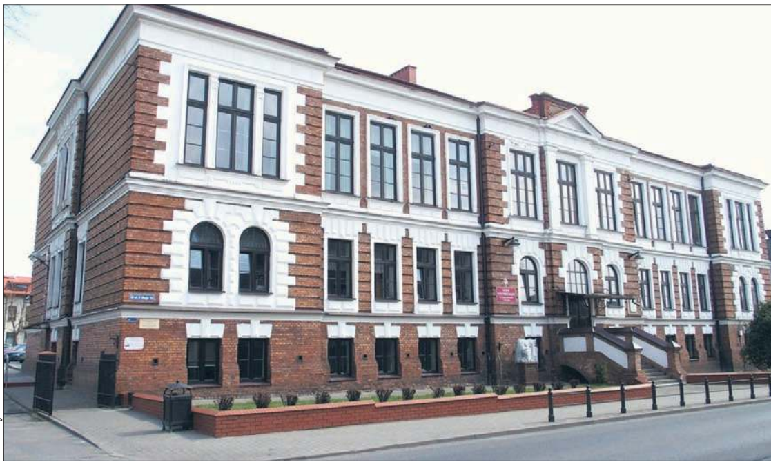
Budynek LO powstał na początku XX wieku
