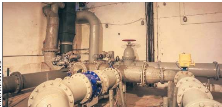
Główne ujęcie wody dla Płocka zostanie zmodernizowane
