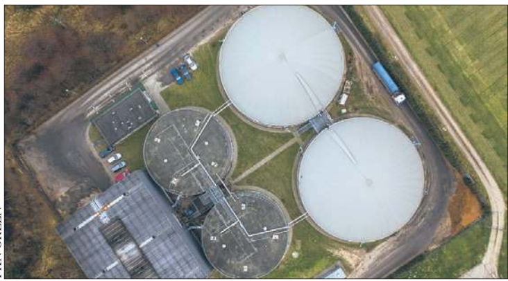
Biogazownia w Konopnicy, gm. Rawa Mazowiecka
