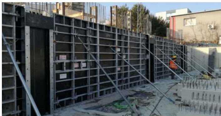
Fot. 2. Deskowanie, w którym linia ściągów nie pokrywa się z linią zamków
