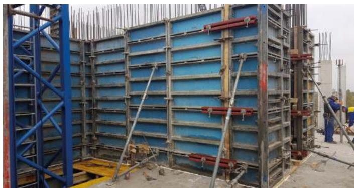
Fot. 1. Deskowanie, w którym linia ściągów pokrywa się z linią zamków
