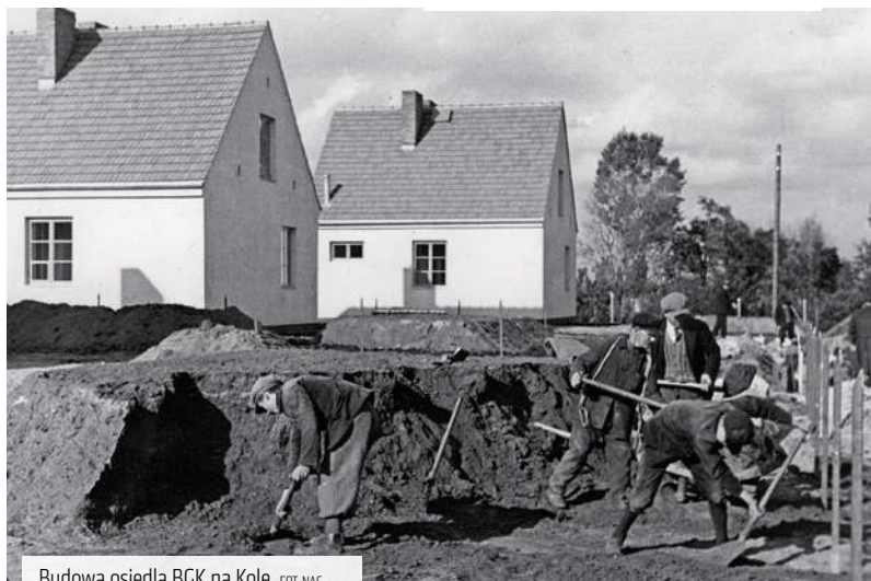
Budowa osiedla BGK na Kole FOT. NAC
