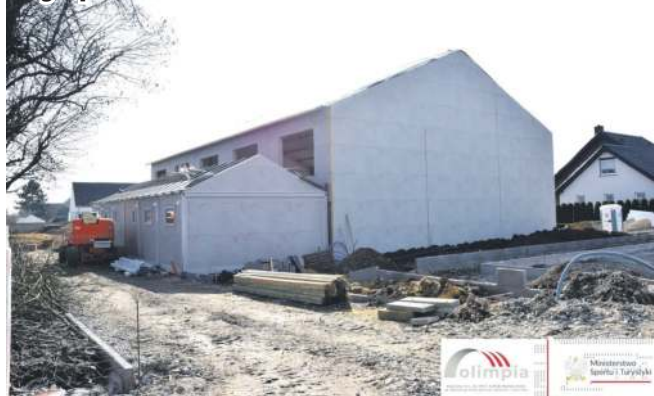
Budowa Olimpii w Szewcach
