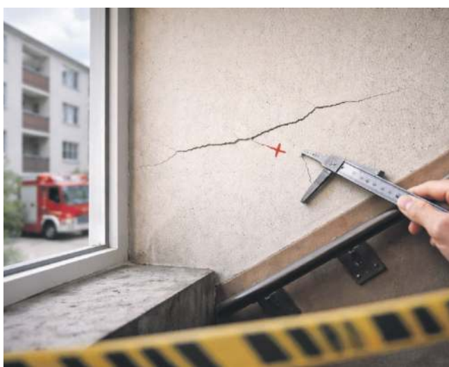
FOT. ZDZIEJCIE POGLĄDOWE
